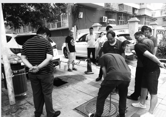
工作人员现场对漏水管线进行检查
